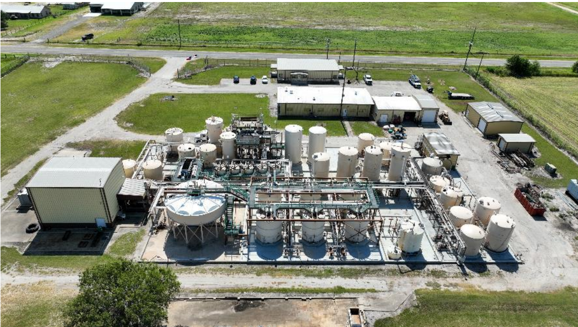
UECs voll lizenzierte Verarbeitungsanlage in Hobson, Südtexas
