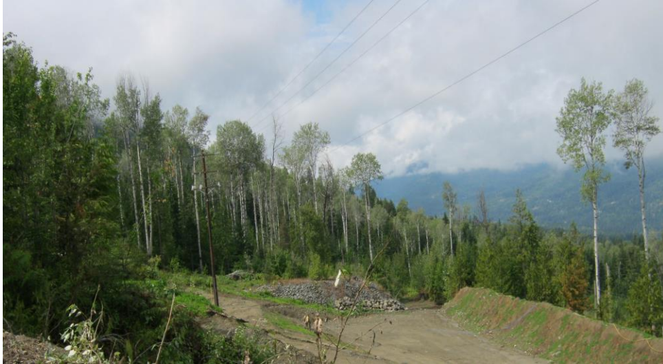
Foto des Standorts des neuen Portals.
