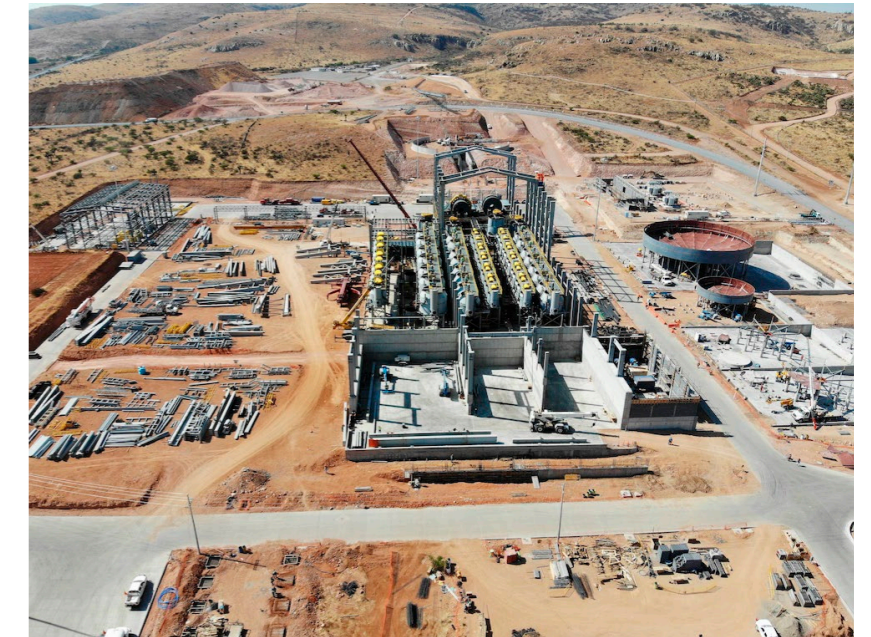
Juanicipio Anlage im Bau. (Quelle MAG Silver)
