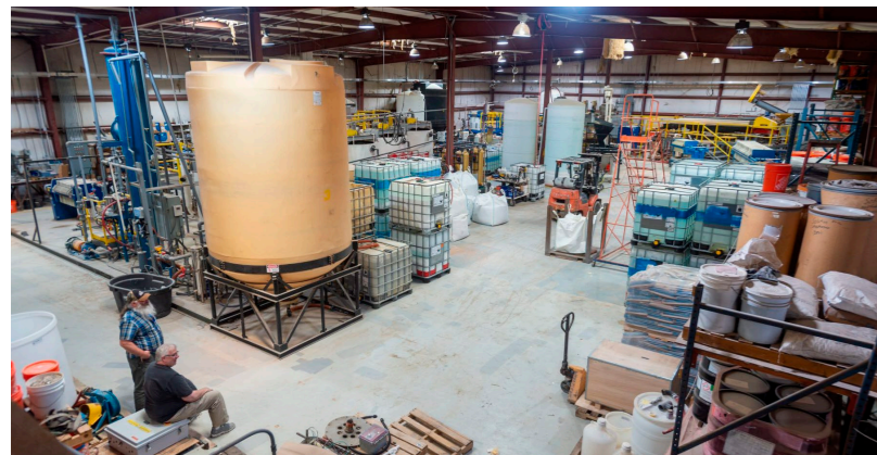
Pilotanlage (Quelle: Century Lithium)
